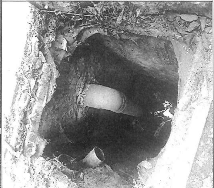
Sistema de alcantarillado con intervenciones para el desagüe, no consideradas en diseño original.
